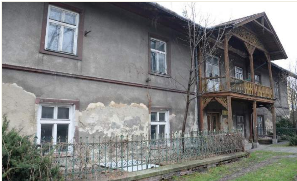
Zdjęcie nr 14 Zły stan techniczny zabytków, fot. Łukasz Chojecki
