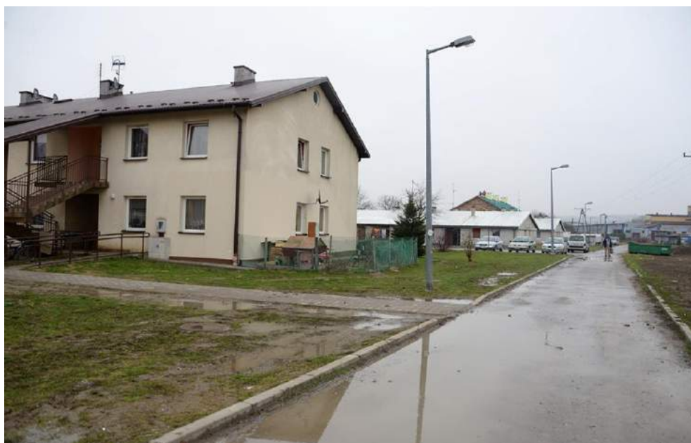
Zdjęcie nr 17 Stan techniczny jednego z budynków Osiedla Socjalnego ul. Na Buczków, fot. Łukasz Chojecki
