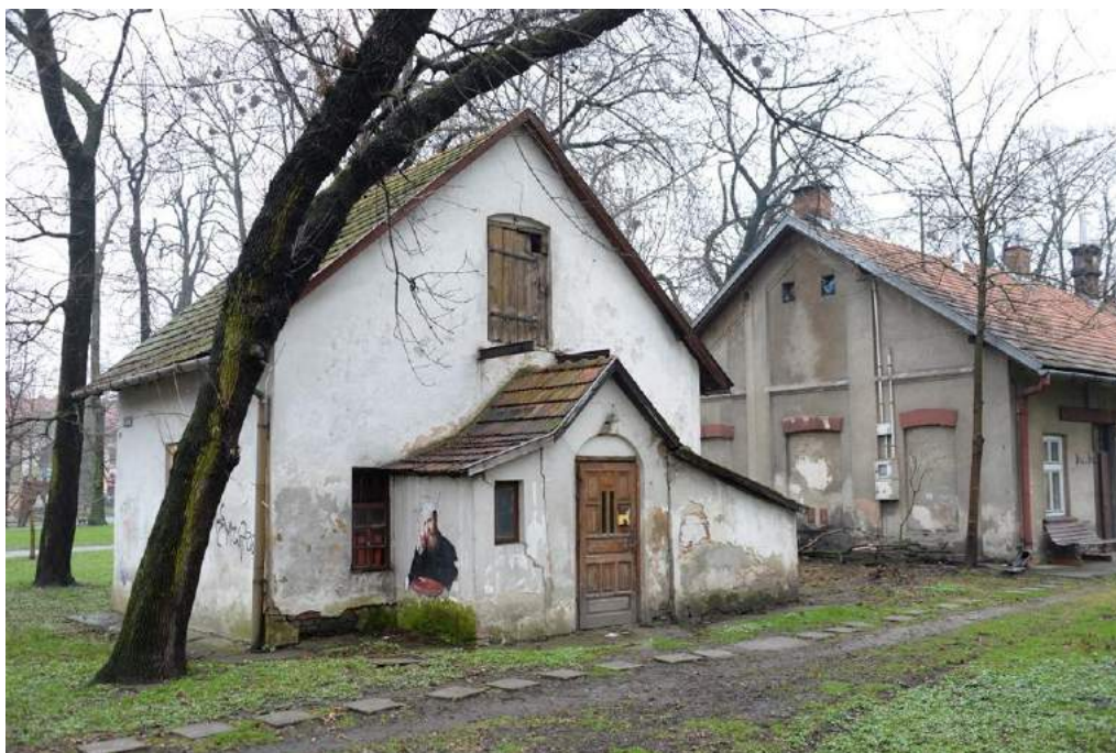
Zdjęcie nr 15 Zły stan techniczny zabytków, fot. Łukasz Chojecki
