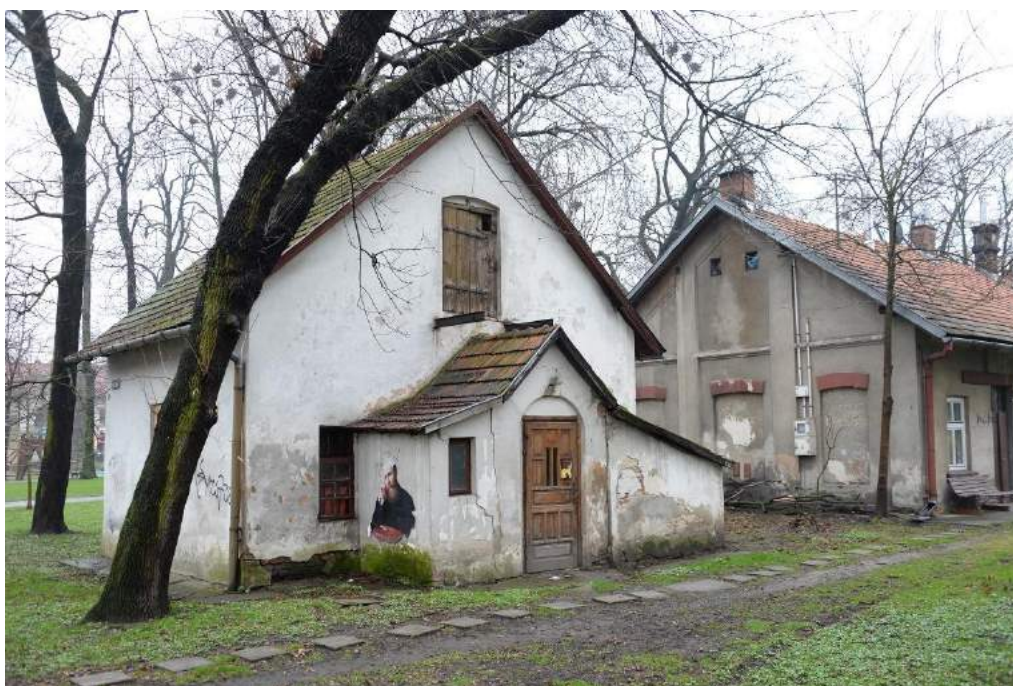
Zdjęcie nr 2 Zły stan techniczny zabytków
