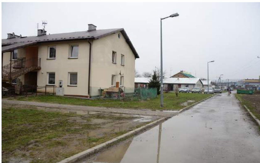
Zdjęcie nr 4 Stan techniczny jednego z budynków osiedla socjalnego Na Buczków.
