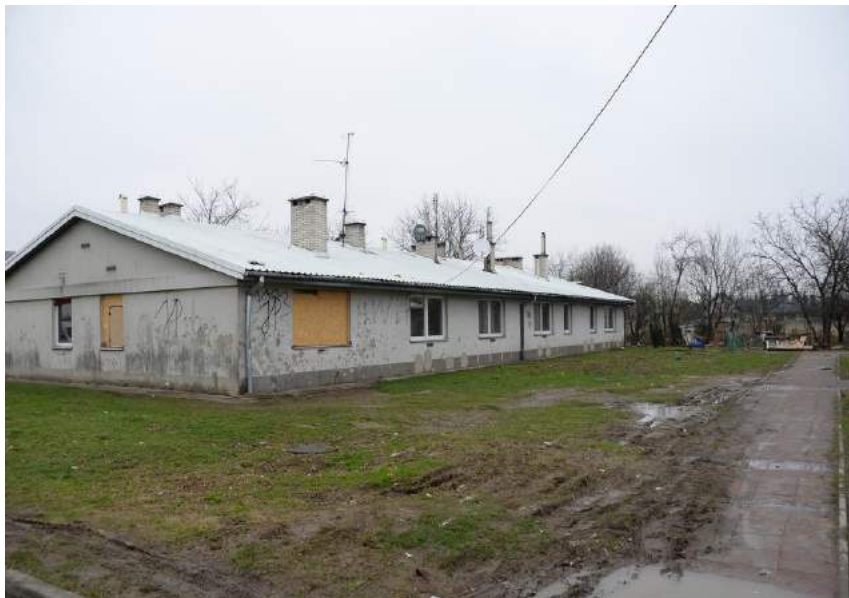
Zdjęcie nr 3 Stan techniczny jednego z budynków osiedla socjalnego Na Buczków.
