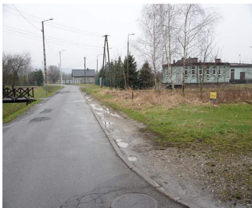
Zdjęcie nr 6 Ulica Na Buczków, główna – brak chodników, po lewej stronie Rów Buczkowski
