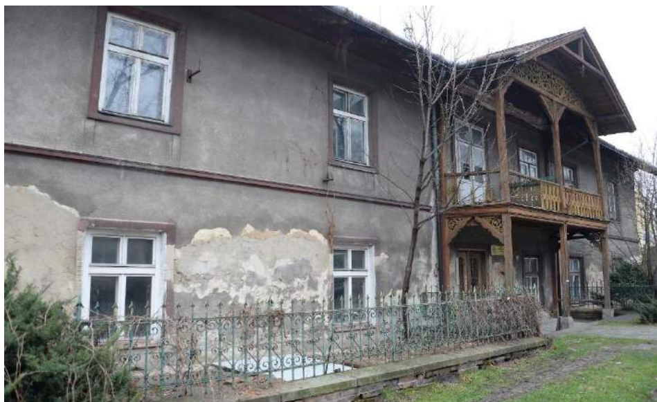
Zdjęcie nr 1 Zły stan techniczny zabytków
